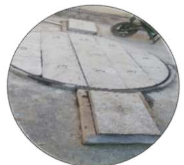
Biodigesteur : là où la fermentation de la boue s'effectue
